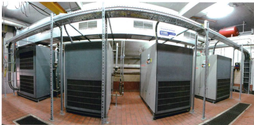
Insgesamt hat Uhl 15 Kompressoren vom Typ „Maxima 75 PLUS“ eingebaut.
