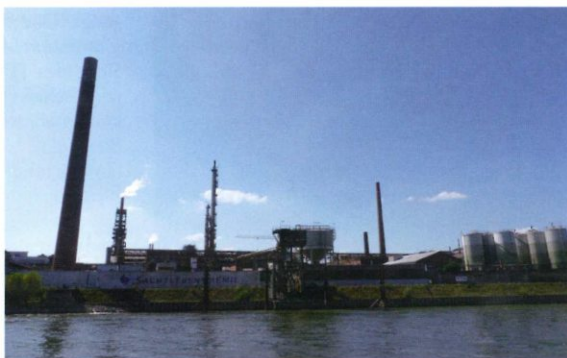
Der Standort Duisburg von Sachtleben Chemie befindet sich unmittelbar am Rhein.
